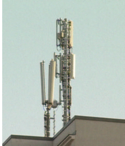
Abb. 4: Benachbarte Antennen müssen „separiert“ werden
